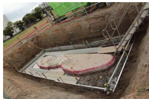
図-9 楕円型改良体 (中型噴射攪拌施工実験から)
