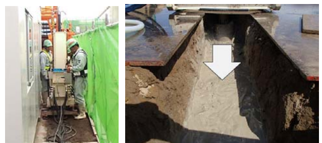
図-10 小型の高圧噴射型施工機械 (左), 地盤改良実施に伴う排泥 (右)
