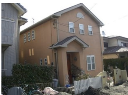
図-1 液状化によって傾斜した直接基礎の建築物
