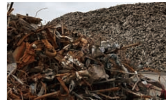
市の北部に位置する片岸町に置かれた災害がれき処理場。膨大な混合廃棄物から、リサイクル可能な木質チップやコンから、金属くずなどを選び分け、再資源化を図っていく。結果、復興資材化可能なリサイクル率は8割以上となった。
